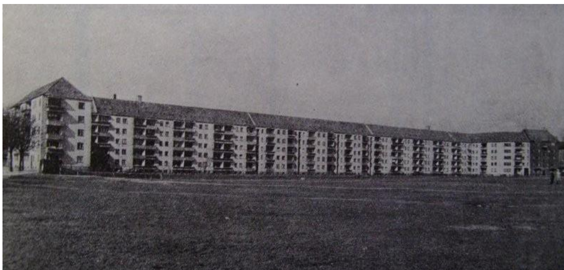
Ejendommen Mariendalshave opført 1932-33 langs Ane Katrines Vej på Frederiksberg ud mod en eng, hvor Ladegårdsåen løb. I dag løber åen i rør under Ågade og Åboulevard og engen er erstattet af parkeringspladser under Bispeengbuen, der binder Ågade sammen med Borups Allé. Foto er taget fra det sted, hvor TDC bygningen med TV tårnet på Borups Alle i dag er beliggende. Ejendommen, der i alt består af 214 boliger, blev af Dansk Financia opdelt i ejerlejligheder i begyndelsen af 1970'erne, hvoraf koncernen pr. 31/12 2018 ejer 6 ejerlejligheder.
